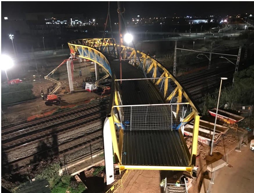
Passarel·la que s'està construint al sector de Ca n'Alemany.
