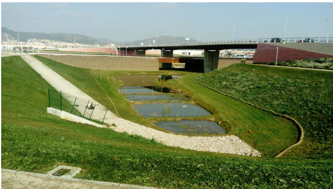
Bassa de laminació per avingudes d'aigua de la riera de Sant Llorenç.
